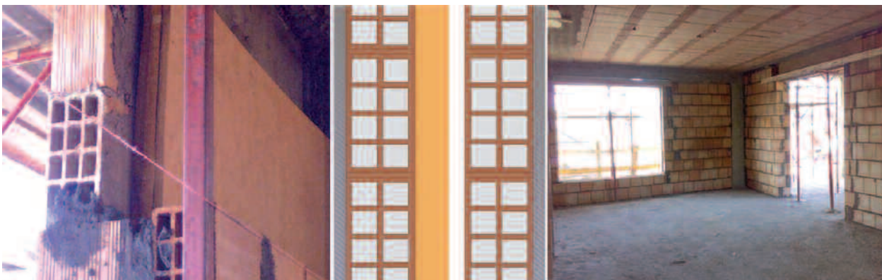
Le partizioni verticali, di 40cm di spessore, sono costituite da una doppia parete in laterizio, coibentata con pannelli in fibra di legno Biopan.
