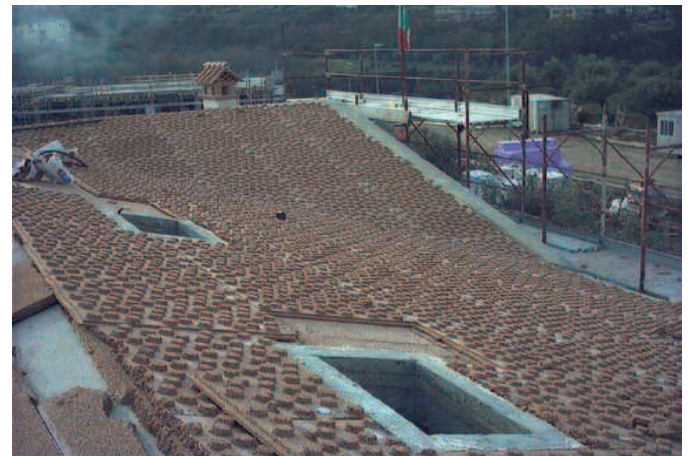
La ventilazione della copertura è garantita dall'utilizzo di pannelli in sughero naturale compresso, ventilato, sagomato a più supporti distanziati rotondi a tronco di cono che permettono una circolazione dell'aria sottotegola.
