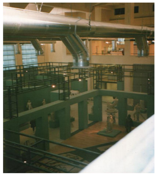
Alcune immagini della fase di realizzazione degli impianti di condizionamento invernale ed estivo e del pavimento radiante per riscaldamento.
